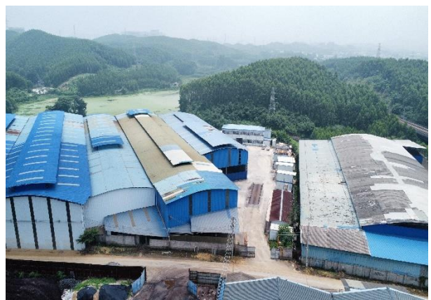
4、项目东面广西联运智慧环保科技有限公司
